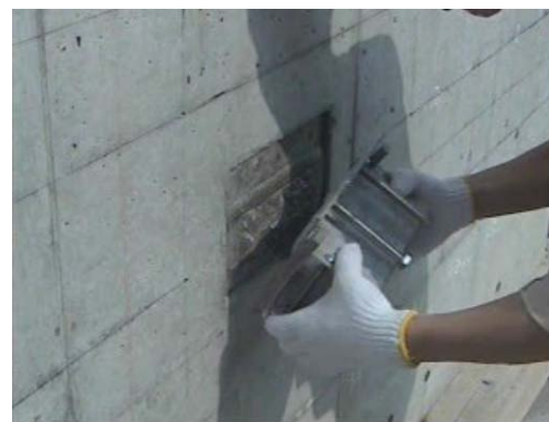
写真 19 ボス型枠の割取り
