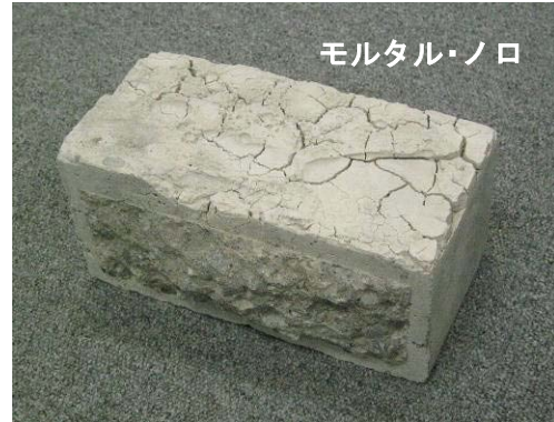
写真15 分離したコンクリート
