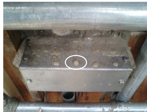
写真13 コンクリートの充填状況の確認
