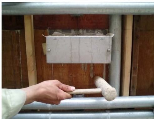
写真12 ボス型枠の充填性の確保
