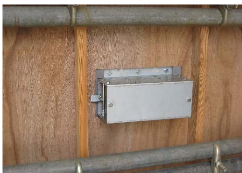
写真 1 ボス型枠の取付け状況
