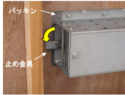
写真11 止め金具による固定
